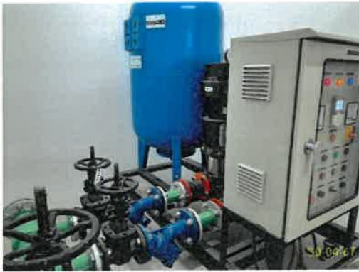
เครื่องสูบน้ำใช้ชั้นดาดฟ้า อาคาร A
