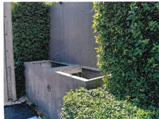
บ่อตรวจคุณภาพน้ำก่อนระบายออกนอกโครงการ ภาพที่ 1.3.6-1 (ต่อ) การระบายน้ำของโครงการ
