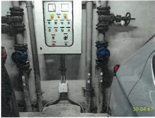
บ่อรับน้ำฝนชั้นใต้ดิน และตู้ควบคุม ตัวที่ 1
