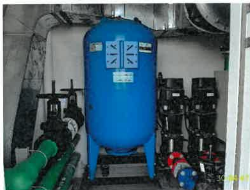
เครื่องสูบน้ำใช้ชั้นดาดฟ้า อาคาร B
