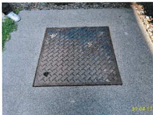
บ่อตรวจคุณภาพน้ำก่อนระบายออกนอกโครงการ ภาพที่ 1.3.6-1 (ต่อ) การระบายน้ำของโครงการ
