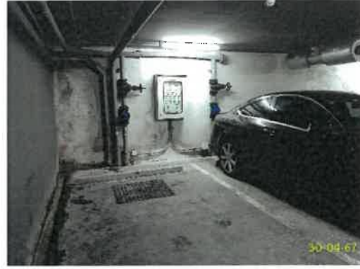
บ่อรับน้ำฝนชั้นใต้ดิน และตู้ควบคุม ตัวที่ 2
