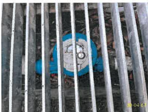
มิเตอร์น้ำประปา ภาพที่ 1.3.4-1 ระบบน้ำใช้
