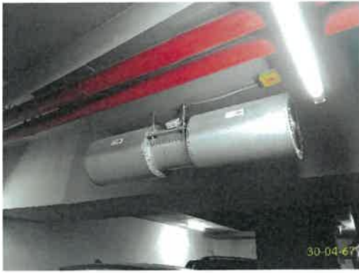
ระบายอากาศที่จอดรถชั้นใต้ดิน
